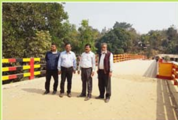
বান্দরবান সদরস্থ বাগমারা বাজার হতে পূর্ব পাড়া যাওয়ার জন্য নোয়াপাড়া খালের উপর ৬০.০০ মিটার আর.সি.সি গার্ডার ব্রীজ নির্মাণ কাজের অগ্রগতি পরিদর্শন করেন বোর্ডের মাননীয় ভাইস-চেয়ারম্যান জনাব তরুণ কান্তি ঘোষ
