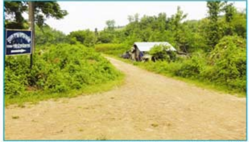
বান্দরবান সদরস্থ সুয়ালক ইউনিয়নে সুয়ালক-বঙ্গপাড়া গণেশপাড়া ৪.৫০ কি.মি. সড়ক নির্মাণ
