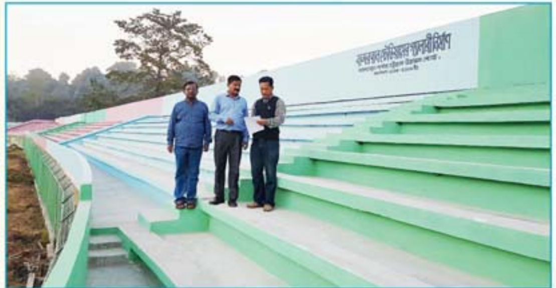
বান্দরবান স্টেডিয়ামের গ্যালারী নির্মাণ কাজের অগ্রগতি পরিদর্শন করেন বোর্ডের মাননীয় ভাইস-চেয়ারম্যান জনাব তরুণ কান্তি ঘোষ (অতিরিক্ত সচিব)
