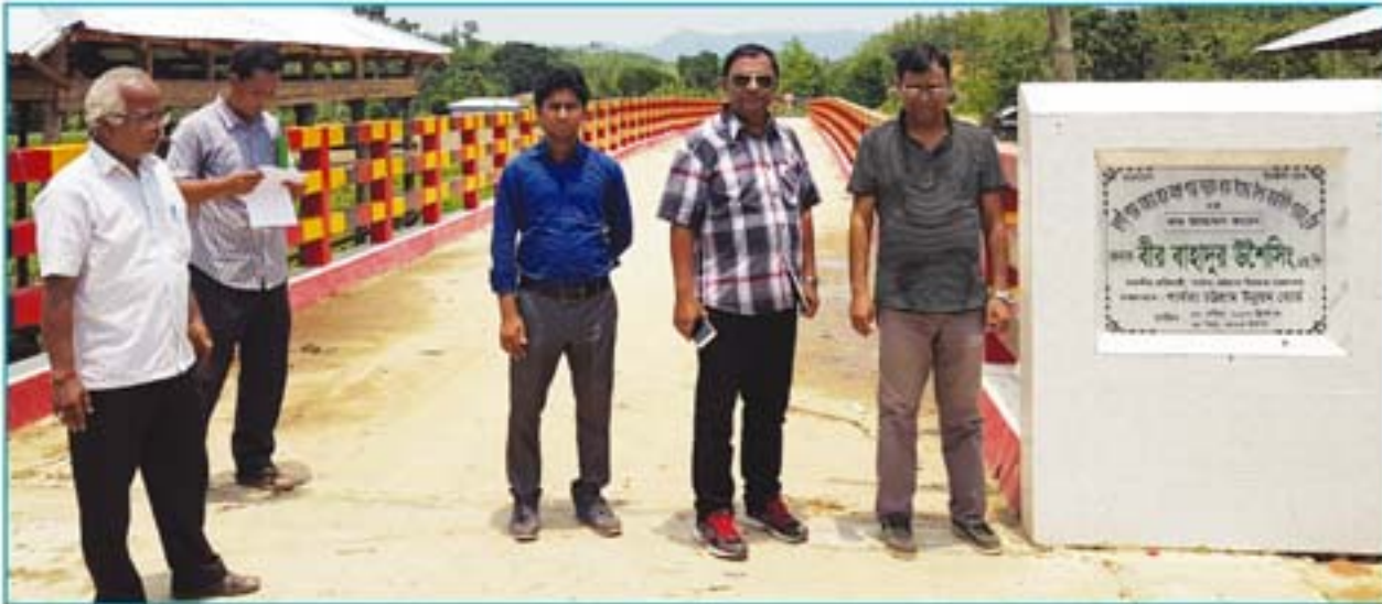
লামা উপজেলাধীন রূপসীপাড়া বাজার হতে মংগ্রু পাড়া সড়কের লামা খালের উপর ৯০.০০ মিটার গার্ডার ব্রীজ নির্মাণ কাজের অগ্রগতি পরিদর্শন করেন বোর্ডের সদস্য-অর্থ জনাব শাহীনুল ইসলাম
