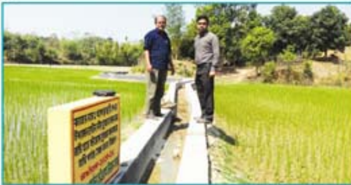
খাগড়াছড়ি সদরস্থ বীর কুমার চাকমার জমি হতে ক্ষীরোদ কুমার চাকমার জমি পর্যন্ত সেচ নালা নির্মাণ
