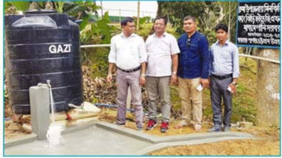
রুমা উপজেলায় মিনকিড়ি পাড়াতে ক্যাং ঝিড়ি হইতে জিএফএস এর মাধ্যমে পানি সরবরাহ কাজের অগ্রগতি পরিদর্শন করেন বোর্ডের সদস্য-অর্থ জনাব শাহীনুল ইসলাম
