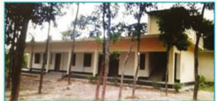
লামা উপজেলার ফাঁসিয়াখালী উচ্চ বিদ্যালয়ের একাডেমিক ভবন নির্মাণ
