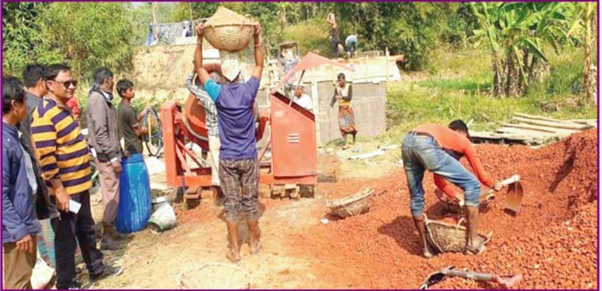
বান্দরবান সদর উপজেলার সুয়ালক-লামা সড়কের টংকাবতী ইউনিয়ন পরিষদ হতে ফুলতলী বাজার হয়ে চিনি পাড়া বাজার পর্যন্ত রাস্তা ও ব্রীজ নির্মাণ কাজের তদারকি করছেন প্রকল্প পরিচালক জনাব মোঃ আবদুল আজিজ।
