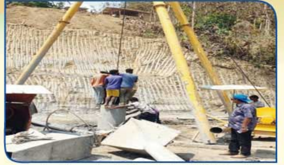
বান্দরবান পার্বত্য জেলায় বলিবার এলাকায় সোনাখালী খালের উপর আর.সি.সি গার্ডার ব্রীজ (৮০.০০ মিটার) নির্মাণ কাজের পিয়ারের পাইলকাস্টিং কাজ পরিদর্শন করেন প্রকল্প পরিচালক জনাব মোঃ আবদুল আজিজ।
