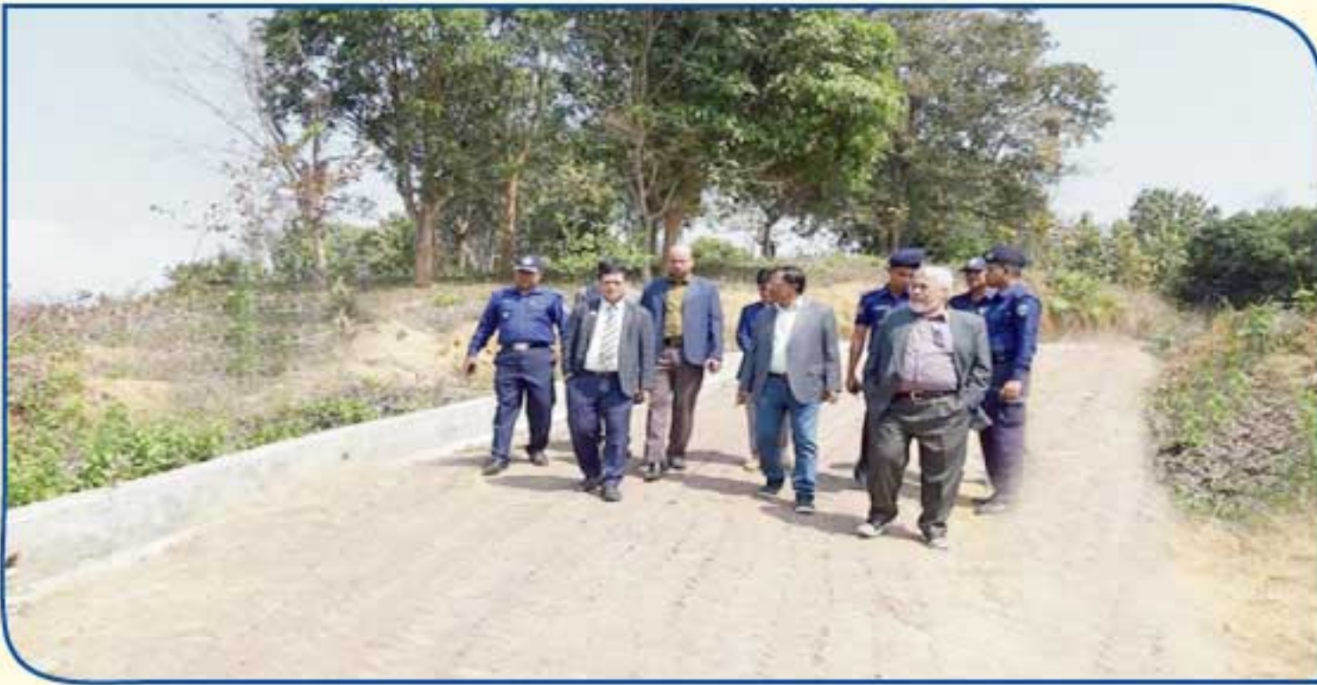
বান্দরবান পার্বত্য জেলায় পল্লী অবকাঠামো উন্নয়ন প্রকল্পের আওতায় রুমা উপজেলার রুমা সদর ইউনিয়নের রুমা সড়ক হতে ডলুঝিড়ি যাওয়ার রাস্তায় ডলুঝিড়ি ছড়ার উপর আরসিসি গার্ডার ব্রীজ নির্মাণ কাজ পরিদর্শন করেন পার্বত্য চট্টগ্রাম বিষয়ক মন্ত্রণালয়ের সচিব জনাব মেসবাহুল ইসলাম।
