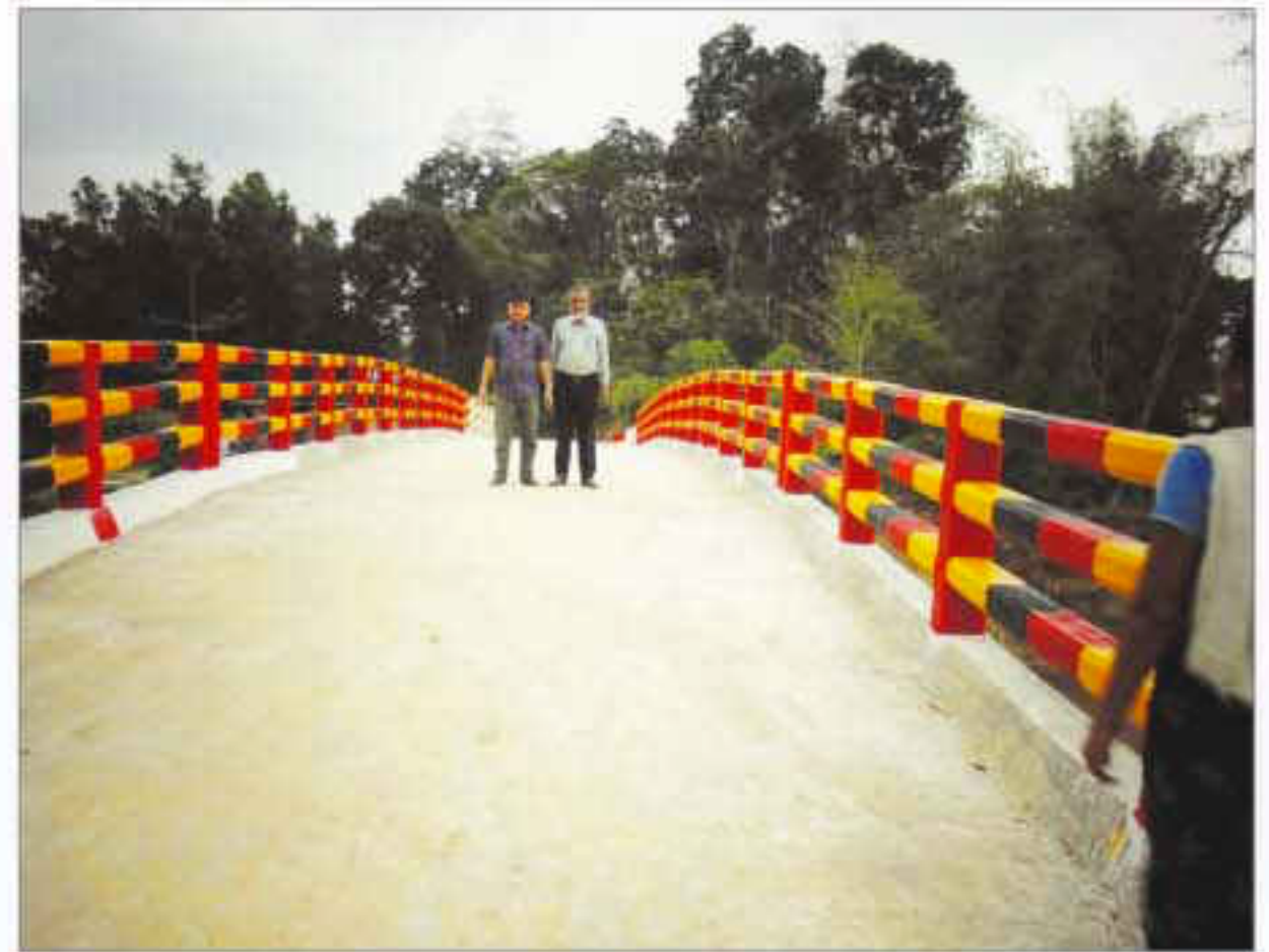
বান্দরবান পার্বত্য জেলার রাজভিলা হতে রমতিয়া সড়কের ব্রীজ নির্মাণ কাজের অগ্রগতি পরিদর্শন করেন বোর্ডের সদস্য-বাস্তবায়ন জনাব মোঃ মনজুরুল আলম
