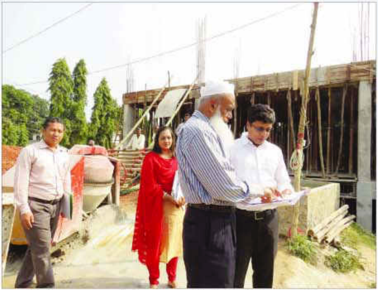
রাঙ্গামাটি পার্বত্য জেলা সদরের পার্বত্য চট্টগ্রাম উন্নয়ন বোর্ডের রেস্ট হাউজ নির্মাণ কাজের অগ্রগতি পরিদর্শন করেন পার্বত্য চট্টগ্রাম বিষয়ক মন্ত্রণালয়ের মাননীয় অতিরিক্ত সচিব জনাব মোঃ সামসুজ্জামান
