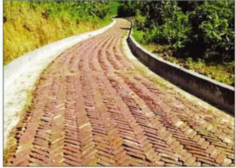
রাঙ্গামাটি পার্বত্য জেলার উপজেলা সদরের গ্রামীণ সড়ক নির্মাণ কাজের খন্ডচিত্র
