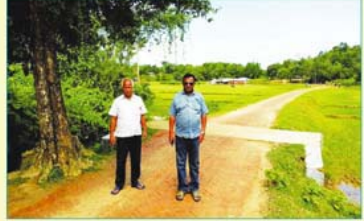
সরই ইউনিয়ন হতে হাসানভিটা রাস্তার মাথা পর্যন্ত রাস্তা নির্মাণ কাজ পরিদর্শনের একাংশ
