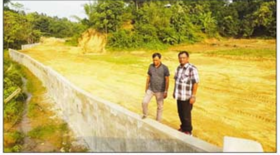
লামা উপজেলাধীন সরই ইউনিয়ন পরিষদ হতে হাসানভিটা রাস্তা মাথা পর্যন্ত রাস্তা নির্মাণ কাজের অগ্রগতি পরিদর্শন করেন বোর্ডের সদস্য-অর্থ জনাব শাহীনুল ইসলাম। সাথে রয়েছেন এ প্রকল্পের প্রকল্প পরিচালক জনাব মোঃ আব্দুল আজিজ।
