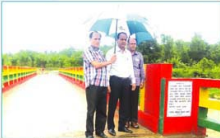
খাগড়াছড়ি উপজেলাধীন ধর্মঘর এলাকায় খাগড়াছড়ি খালের উপর ৩০.৪৮ মিটার দীর্ঘ আরসিসি ব্রীজ নির্মাণ কাজের অগ্রগতি পরিদর্শন করছেন বোর্ডের সদস্য-পরিকল্পনা জনাব ড. প্রকাশ কান্তি চৌধুরী
