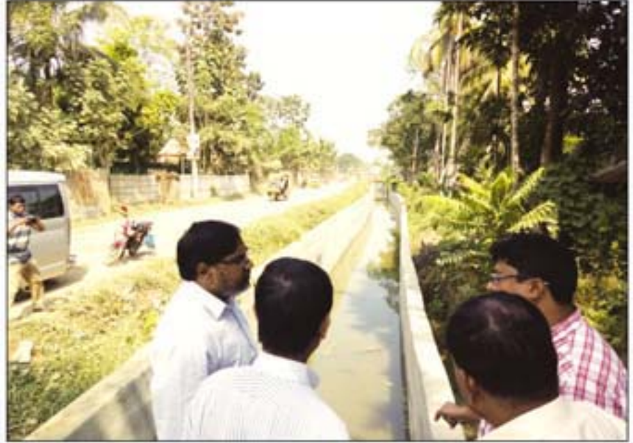
পার্বত্য চট্টগ্রামের খাগড়াছড়ি জেলার সদর উপজেলার জনগণের জীবনযাত্রার মান উন্নয়নের লক্ষ্যে নয়নপুর মসজিদ হতে বটতলী পর্যন্ত মাটির ড্রেইন নির্মাণ কাজের অগ্রগতি পরিদর্শন করেন পরিকল্পনা কমিশনের উর্ধ্বতন কর্তৃপক্ষ
