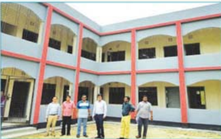
কুমা উপজাতীয় আবাসিক উচ্চ বিদ্যালয়ে ছাত্রী হোস্টেল নির্মাণ কাজের অগ্রগতি পরিদর্শন করেন আইএমইডি প্রতিনিধিগণ
