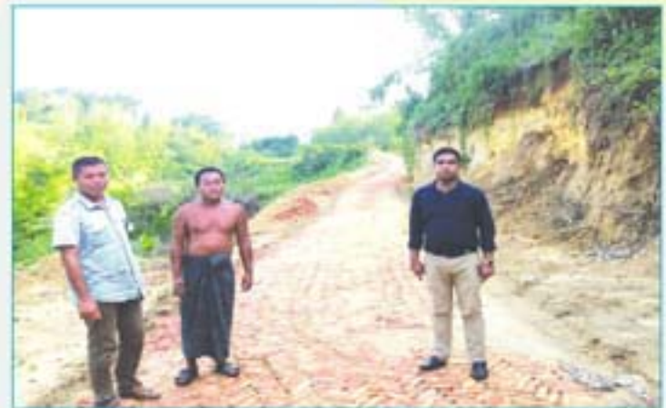
পার্বত্য চট্টগ্রাম উন্নয়ন বোর্ড কর্তৃক নির্মিত মাটিরাস্তা উপজেলাধীন সাপমারা বড় ব্রীজ হতে প্রেম রঞ্জন কার্বারী পাড়া পর্যন্ত রাস্তা নির্মাণ কাজের চিত্র
